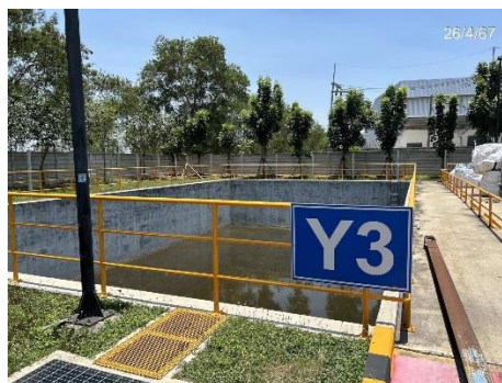
ภาพที่ 2-27 บ่อหน่วงน้ำฝนของโครงการ
