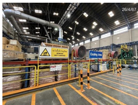
ภาพที่ 2-23 พัดลมระบายอากาศ บริเวณเสี่ยง ต่อการสะสมความร้อน
